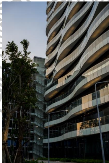
ภาพที่ 6 ภาพภายนอกตึกในกรุงเทพฯ มุมมองแบบ Ant eye view ที่มา : Northern Corridor, SCG Headquarter , เข้าถึงเมื่อ 29 มิถุนายน 2559, เข้าถึงได้จาก http://www.skyscrapercity.com/showthread.php?p=109080997#post109080997
