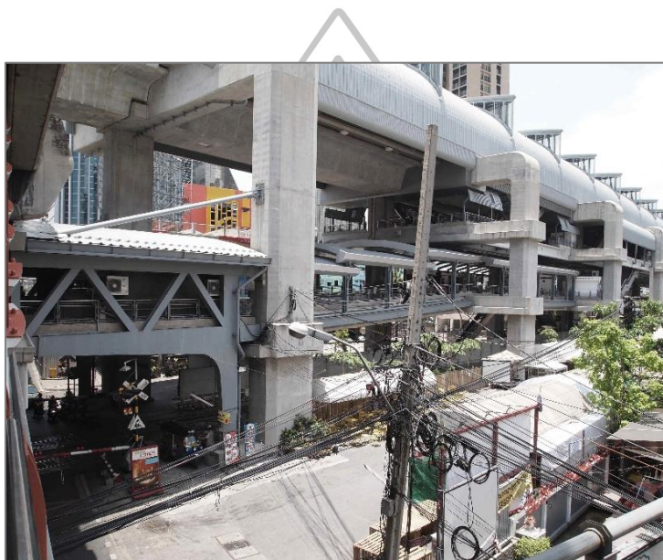
ภาพที่ 5 โครงสร้างของสถานีรถไฟฟ้าแอร์พอร์ตลิงค์(Airport Rail Link) กรุงเทพมหานคร
