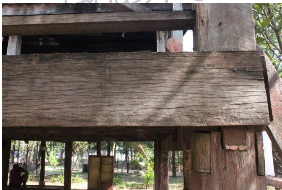
ภาพที่ 2 ภาพแสดงลักษณะของการเข้าไม้ใต้ถุนบ้าน(ภาคอีสาน)
