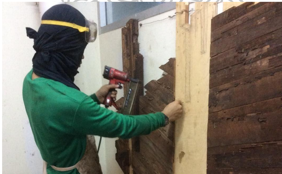
ภาพที่ 22 ภาพแสดงลักษณะการยิงปืนลมลงบนแผ่นไม้กับไม้อัด
