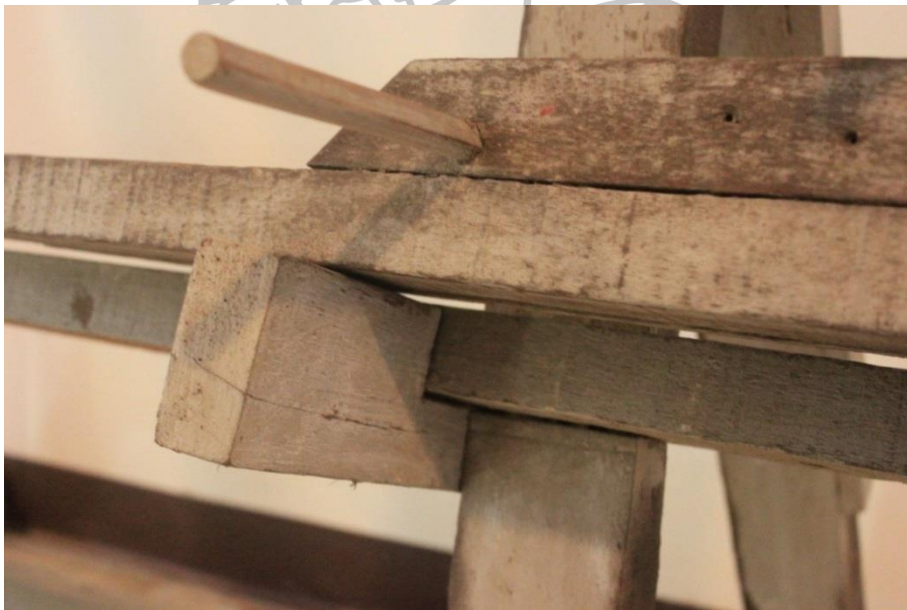
ภาพที่ 6 ภาพแสดงลักษณะของการบากไม้และการเข้าเตี้ยไม้(หลักเฟีย ใช้ในการค้ำฝ้าย)
