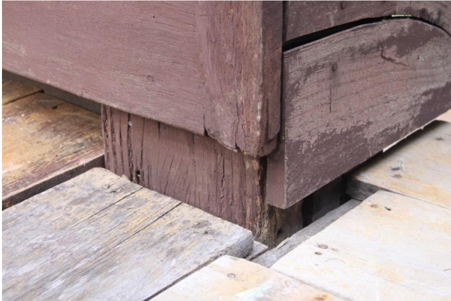
ภาพที่ 5 ภาพแสดงลักษณะของการเข้าไม้บริเวณมุมเสา
