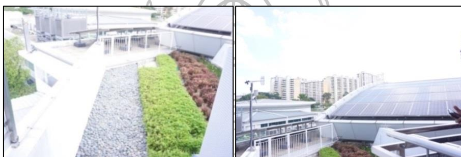
ภาพที่ 19 แสดง Green Roof ของอาคาร ZEB at BCA Academy (ถ่ายโดยผู้วิจัย ณ อาคาร ZEB at BCA Academy เมื่อพฤษภาคม 2558)
