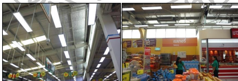
ภาพที่ 11 แสดงบรรยากาศภายในอาคารส่วนของระบบไฟฟ้าแสงสว่าง และช่องแสงด้านข้าง
