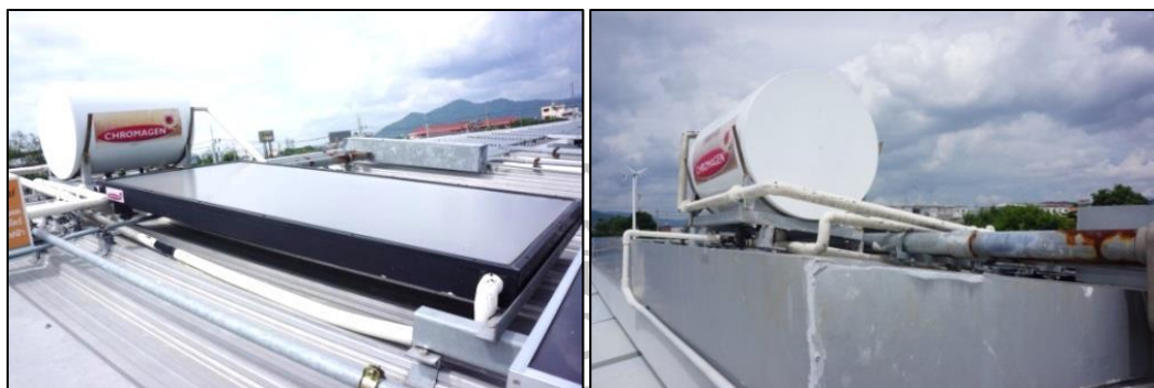
ภาพที่ 14 แสดงเครื่องทำความร้อน ด้วยพลังงานแสงอาทิตย์ อาคาร Zero Carbon Store Tesco Lotus (ตลาดโลตัส) (ถ่ายโดยผู้วิจัย ณ อาคาร Zero Carbon Store Tesco Lotus เมื่อกรกฎาคม 2558)
