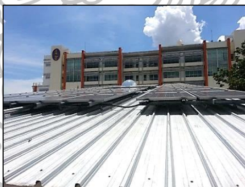
ภาพที่ 9 การติดตั้งแผงเซลล์แสงอาทิตย์บนหลังคาอาคารกongsarongkor มหาวิทยาลัยขอนแก่น (ถ่ายโดยผู้วิจัย ณ อาคารกongsarongkor มหาวิทยาลัยขอนแก่น เมื่อมิถุนายน 2558)
