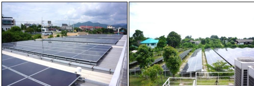
ภาพที่ 13 แสดงพื้นที่ติดตั้งแผงเซลล์แสงอาทิตย์บนหลังคาและฟาร์มโซลาร์เซลล์ (ถ่ายโดยผู้วิจัย ณ อาคาร Zero Carbon Store Tesco Lotus เมื่อกรกฎาคม 2558)
