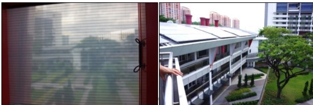
ภาพที่ 20 แสดงแผงเซลล์แสงอาทิตย์ที่ทำหน้าที่เป็น façade และแผงเซลล์แสงอาทิตย์บนหลังคา (ถ่ายโดยผู้วิจัย ณ อาคาร ZEB at BCA Academy เมื่อพฤษภาคม 2558)
